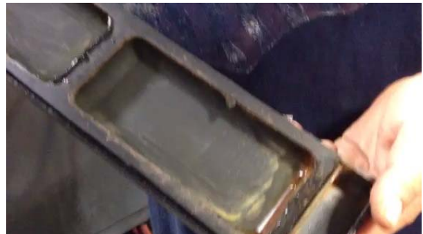
Imagen 2: superficies de refrigeración tratadas con BCP™ 1015 libres de deposición
